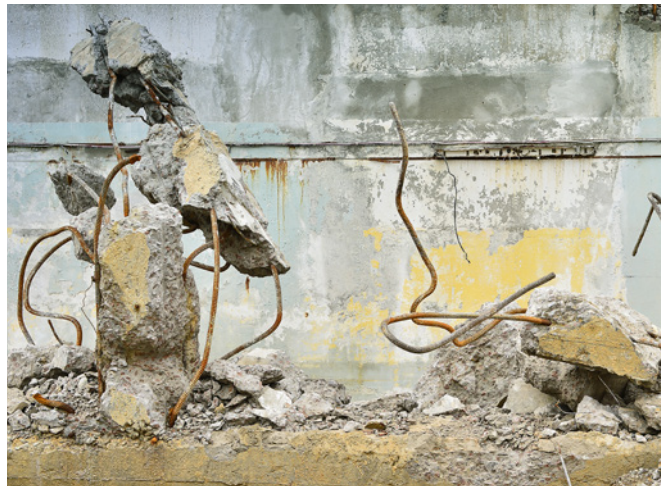
Béton de démolition
